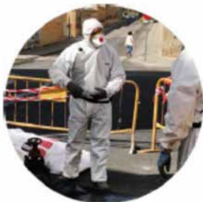
Fig. 11. Equipamiento de un operario para la realización de trabajos en presencia de amianto.
