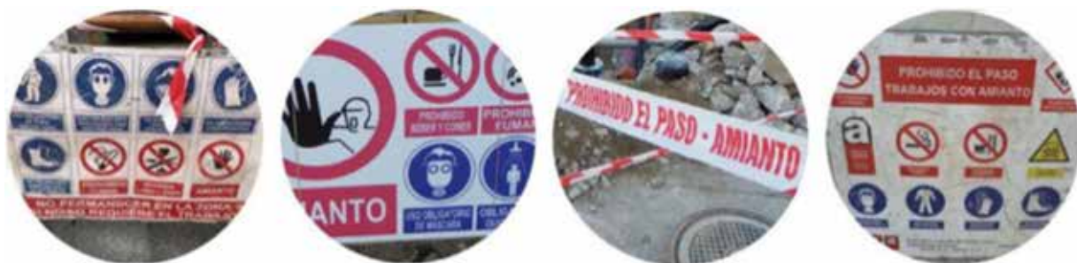
Fig. 6. Varios ejemplos de señalización y delimitación de la zona de trabajo de diversas obras.
