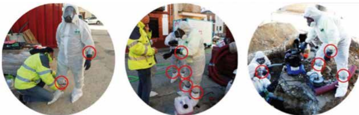
Fig. 7. Operarios asegurando los EPIs de las extremidades de los trabajadores mediante el encintado.
